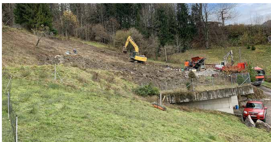
■ Alle Wohnhäuser sind zurückgebaut und das Gebiet wurde renaturiert.
